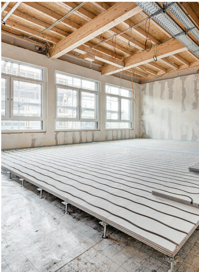
Fläche während der Montage
