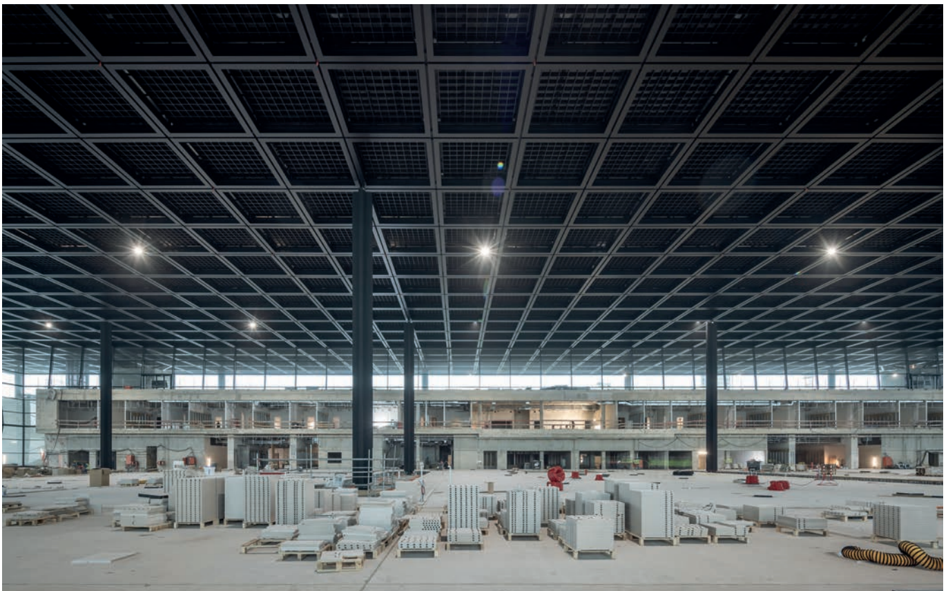
Flughafen Frankfurt Check-in Halle Gebäude 600, Frankfurt, Deutschland
