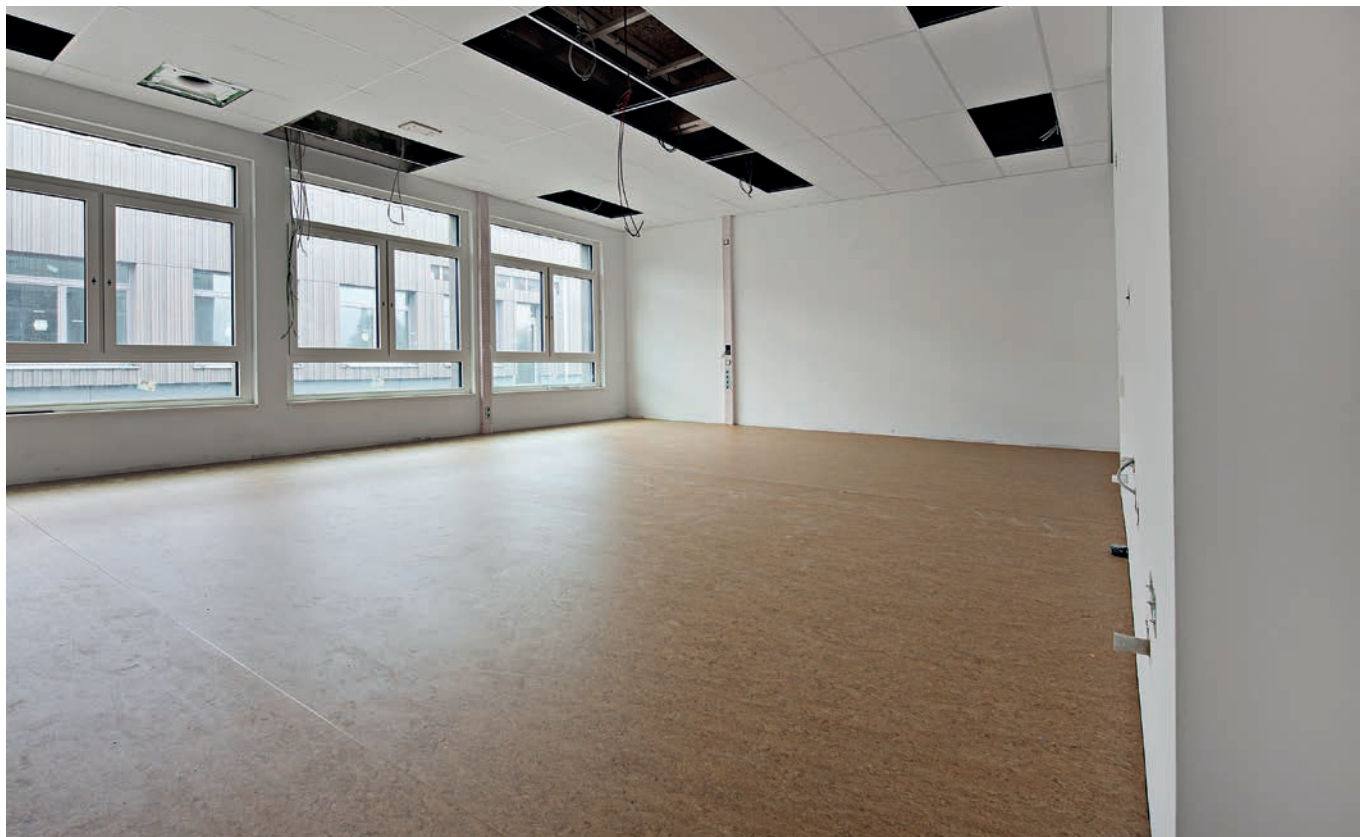
Fertige Leistung Trockenhohlboden FLOOR and more® comfort, Oberbelag Linoleum
