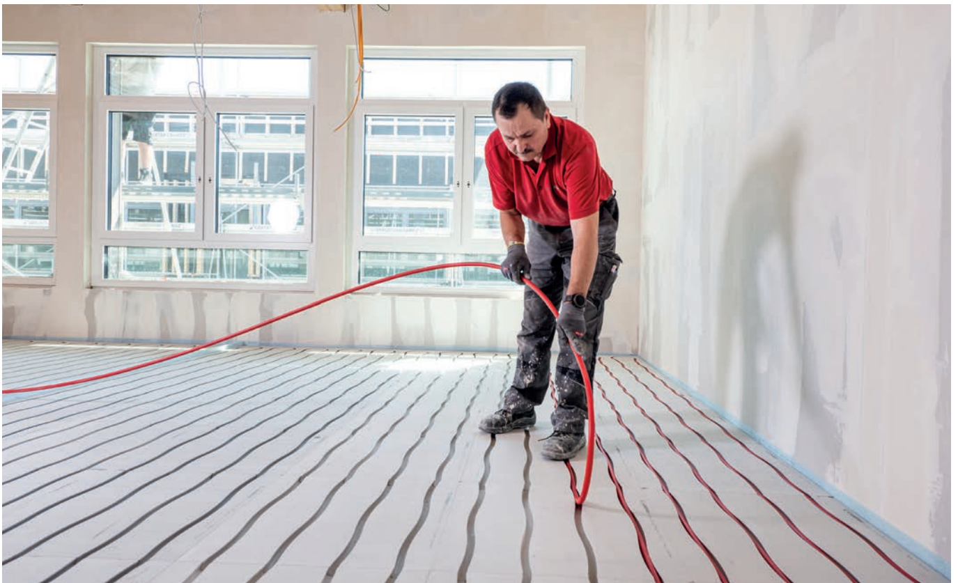
Verlegung der Heizrohre
