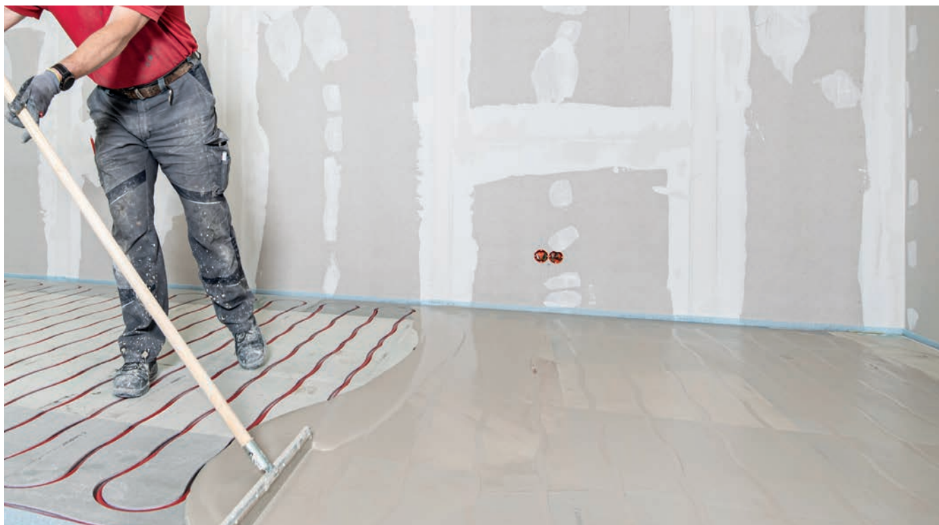
Verfüllung Heizleitungen mit Spachtelmasse
