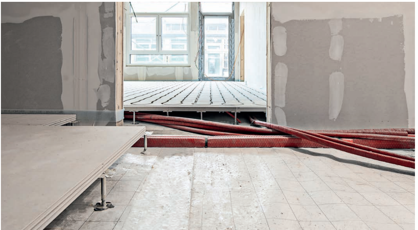
Fertig verlegte Fläche mit Anbindleitungen im Bodenhohlraum
